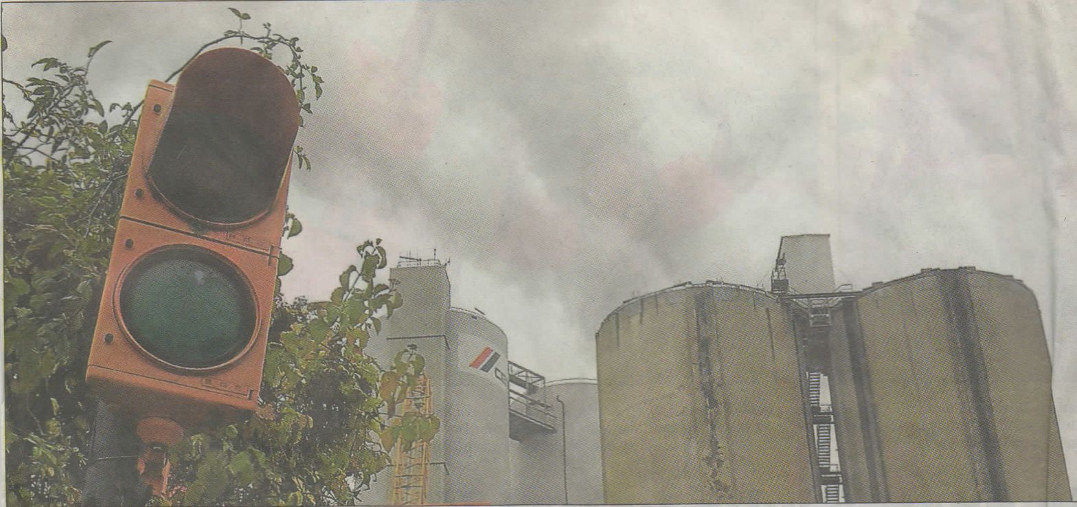
Grünes Licht für den Eigentümerwechsel: Das Zementwerk am Kollenbach steht vor tiefgreifenden Veränderungen. Der Abschluss der Transaktion wird im Laufe des ersten Quartals 2015 erwartet. Bild: Grünoaum
