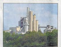
Der alte Elektrofilter im Zementwerk Ennigerloh wird durch einen modernen Gewebefilter ersetzt. Das Werk plant eine 15-Millionen-Euro-Investition.
