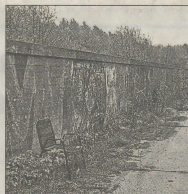
Nord, Ruhr & Co. KG in Beckum (1909 bis 1971). Erhalten ist die Werksmauer und das ehemalige Verwaltungsgebäude.
